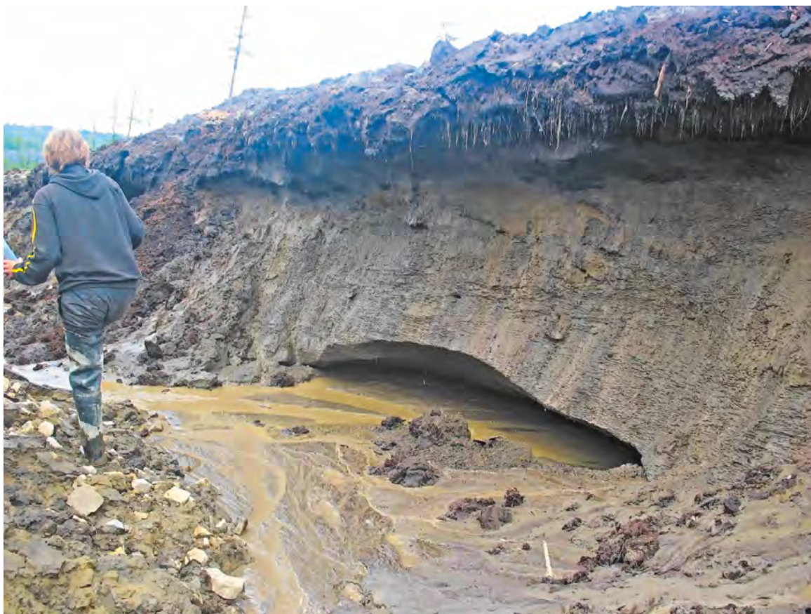
Рис. 1. Подземные льды в борту канавы по трассе (фото Ф. Зепалова)
